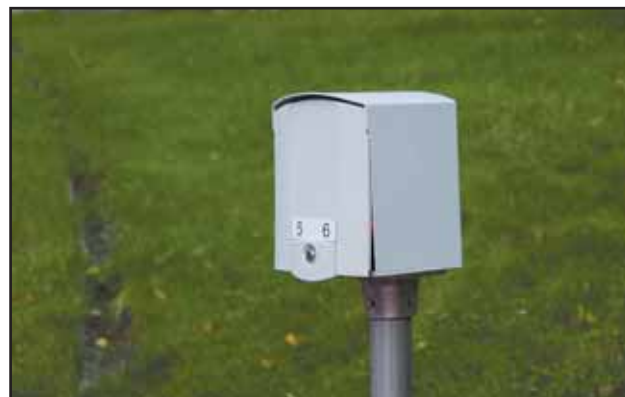
Olemme toteuttaneet autolämmityspistorasioiden asennuksia mm.: As. Oy Jyväskylän Saunatie 1 ja As. Oy Jyväskylän Saunatie 2, As. Oy Keskustie 19 sekä As. Oy Kolmosvahti.
